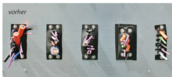
Brandschutzmatten an der dem Feuer zugewandten Seite:
